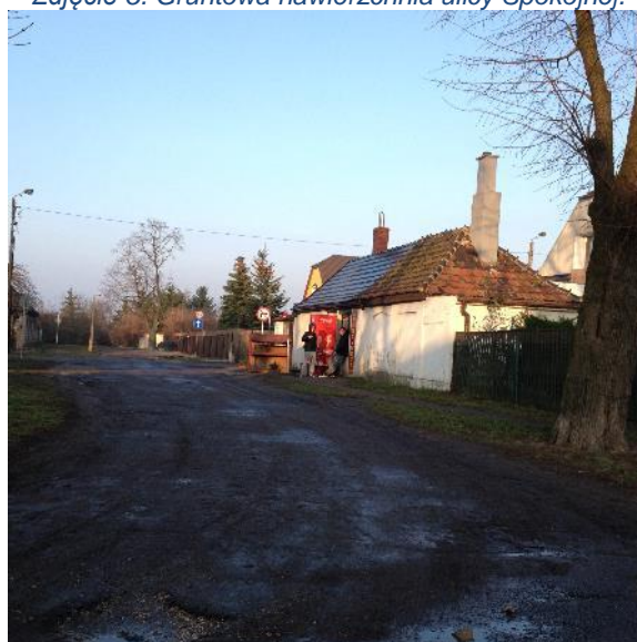
Zdjęcie 5. Gruntowa nawierzchnia ulicy Spokojnej.
