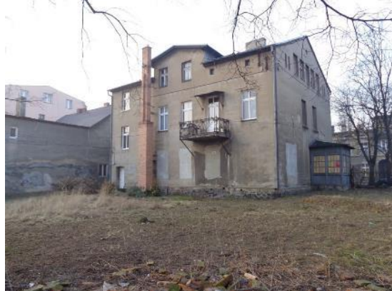
Zdjęcie 1. Budynek z 1880 roku przy ul. Toruńskiej 24 użytkowany przez Towarzystwo Brata Św. Alberta
