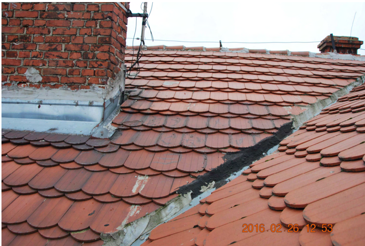
fot.3 Widok dachu od strony zachodniej
