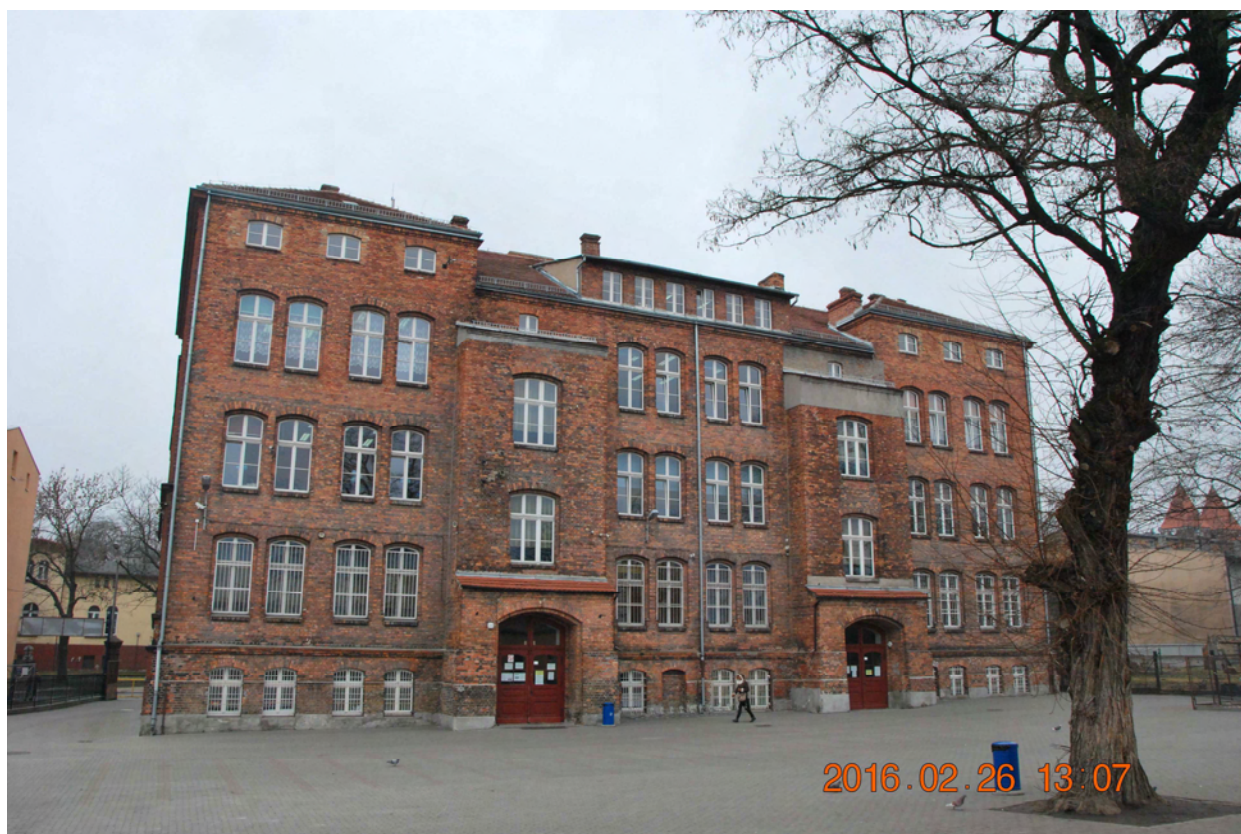
fot.2 Widok dachu od strony wschodniej
