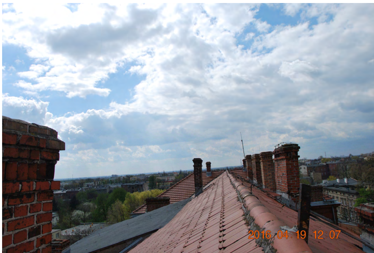
fot.6 Widok dachu od strony zachodniej i wschodniej wzdłuż głównej kalenicy.
