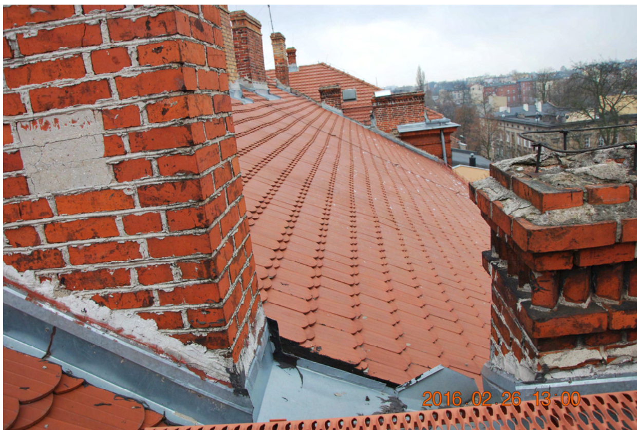
fot.5 Widok dachu od strony zachodniej
