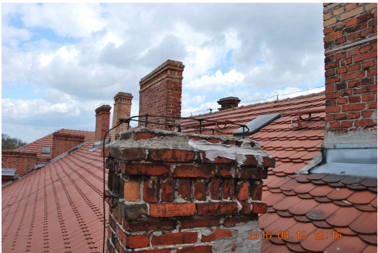
fot.10 Widok dachu od strony zachodniej
