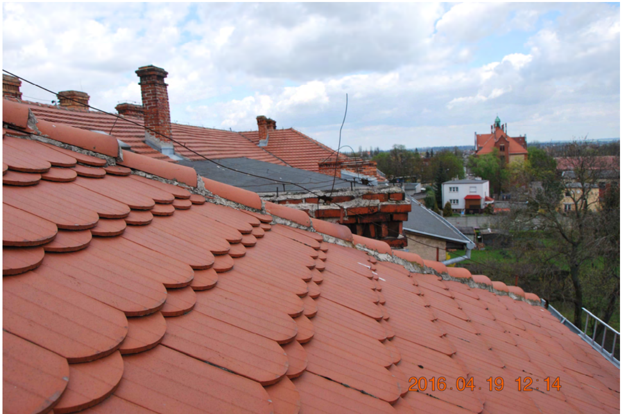
fot.9 Widok dachu od strony wschodniej
