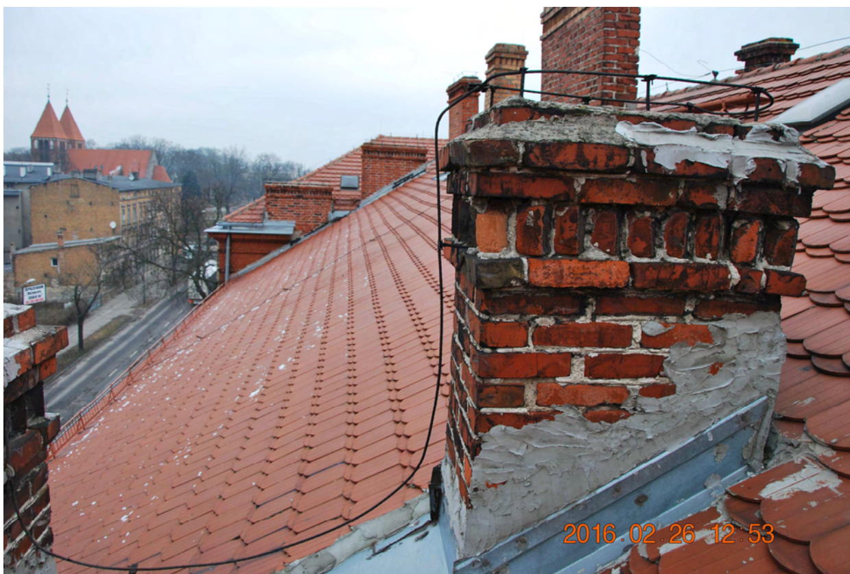
fot.4 Widok dachu od strony zachodniej
