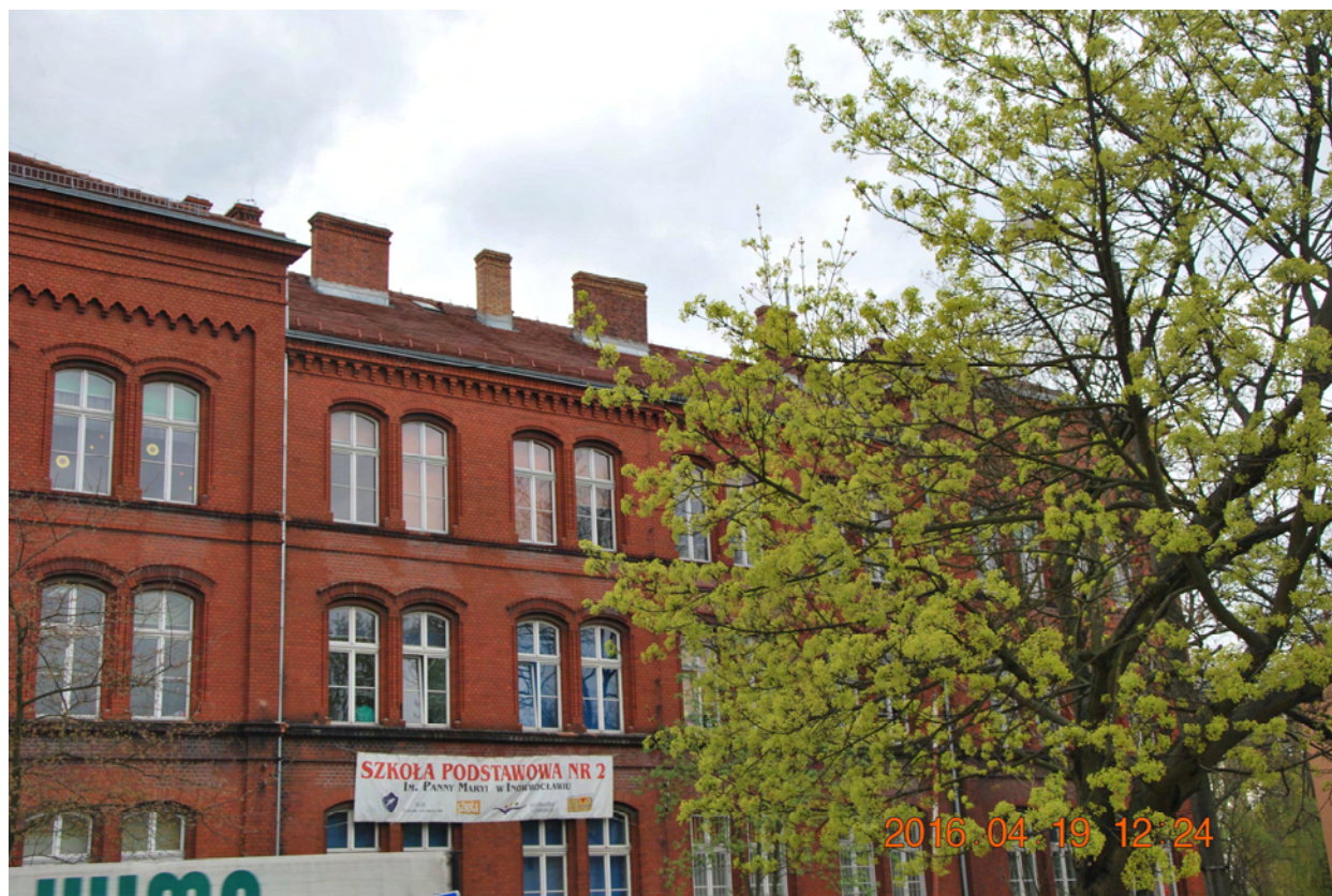
fot.1 Widok dachu od strony zachodniej
