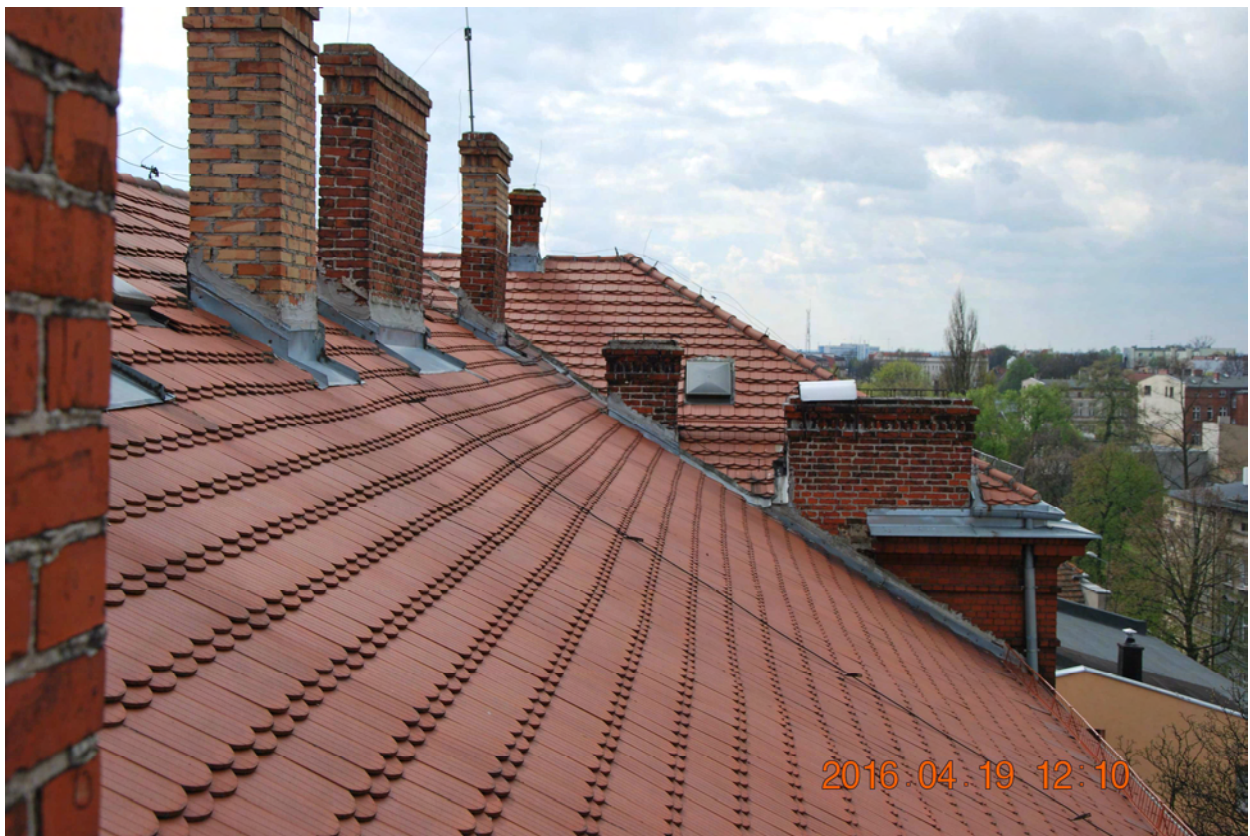
fot.8 Potać od strony zachodniej
