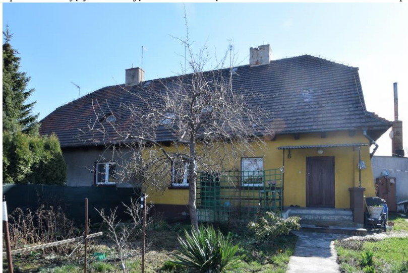
widok w kierunku południowym
