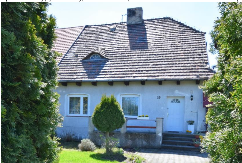
widok w kierunku południowym
