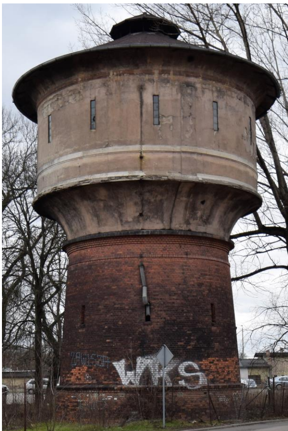
widok w kierunku zachodnim na elewację wschodnią i północną
