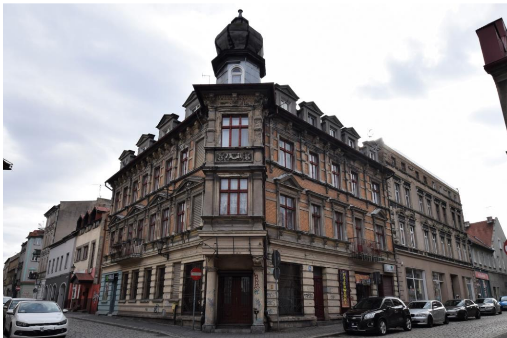
widok w kierunku południowo-zachodnim
