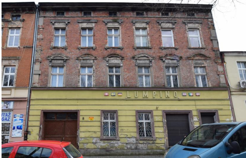
widok w kierunku południowo- wschodnim
