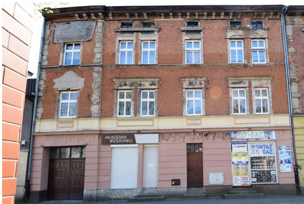
widok w kierunku południowo-wschodnim
