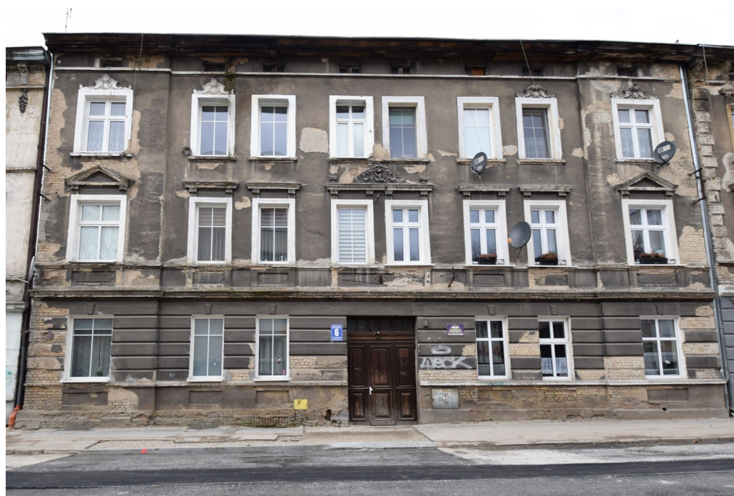
widok w kierunku północno-zachodnim
