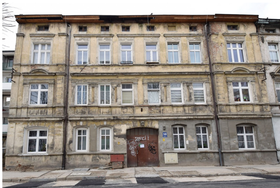
widok w kierunku północno-zachodnim
