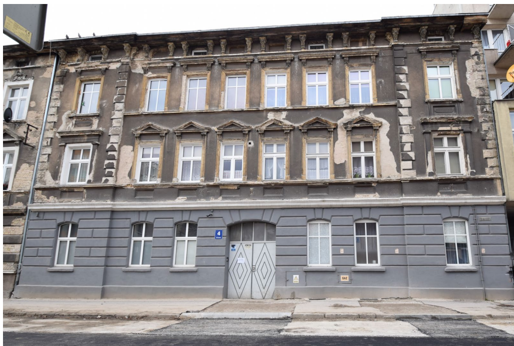
widok w kierunku północno-zachodnim
