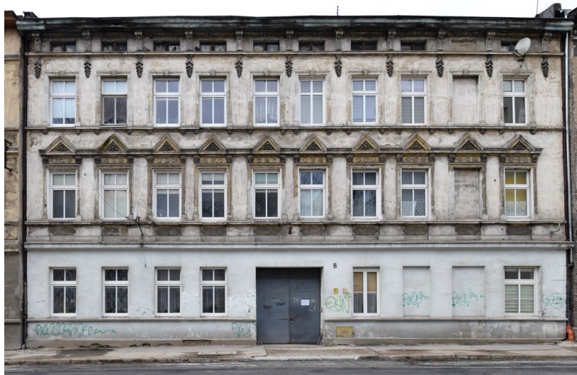
widok w kierunku północno-zachodnim
