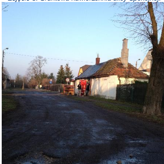
Zdjęcie 5. Gruntowa nawierzchnia ulicy Spokojnej.
