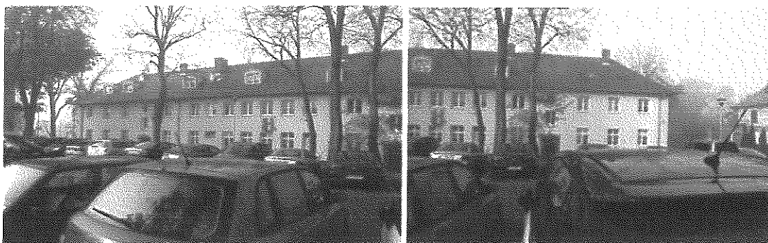
Fot. 4 Elewacja wschodnia kontrolowanego budynku (wykonał: kpt. Jarosław Skotnicki)
