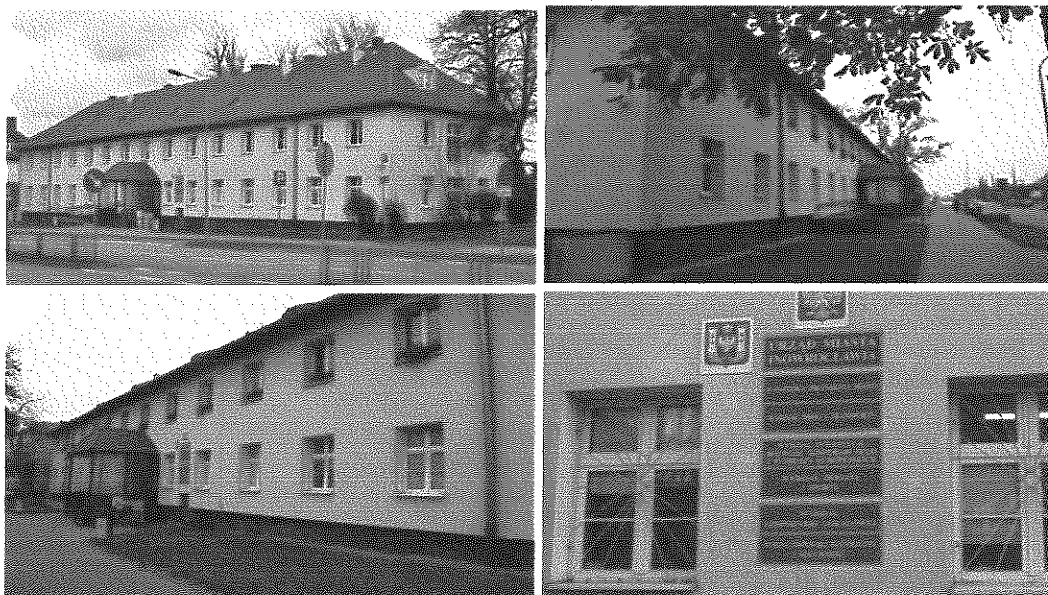
Fot.3 Elewacja zachodnia kontrolowanego budynku (wykonał: kpt. Jarosław Skotnicki)
