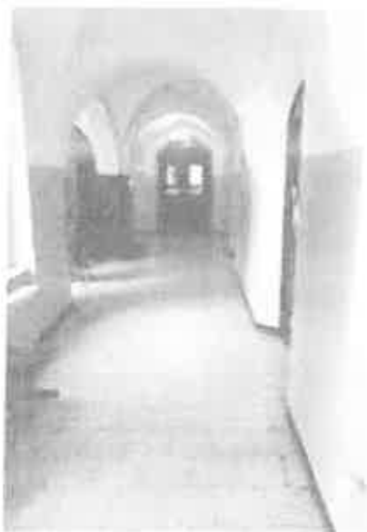
Fot.29 Budynek UM Inowrocław – Rańsz – Poziomy odcinek dojścia ewakuacyjnego nr 1 na I kondygnacji nadziemnej w skrzydle A1 do wejścia do klatki K2 (wykonał mł. asp. Maciej Borys)
