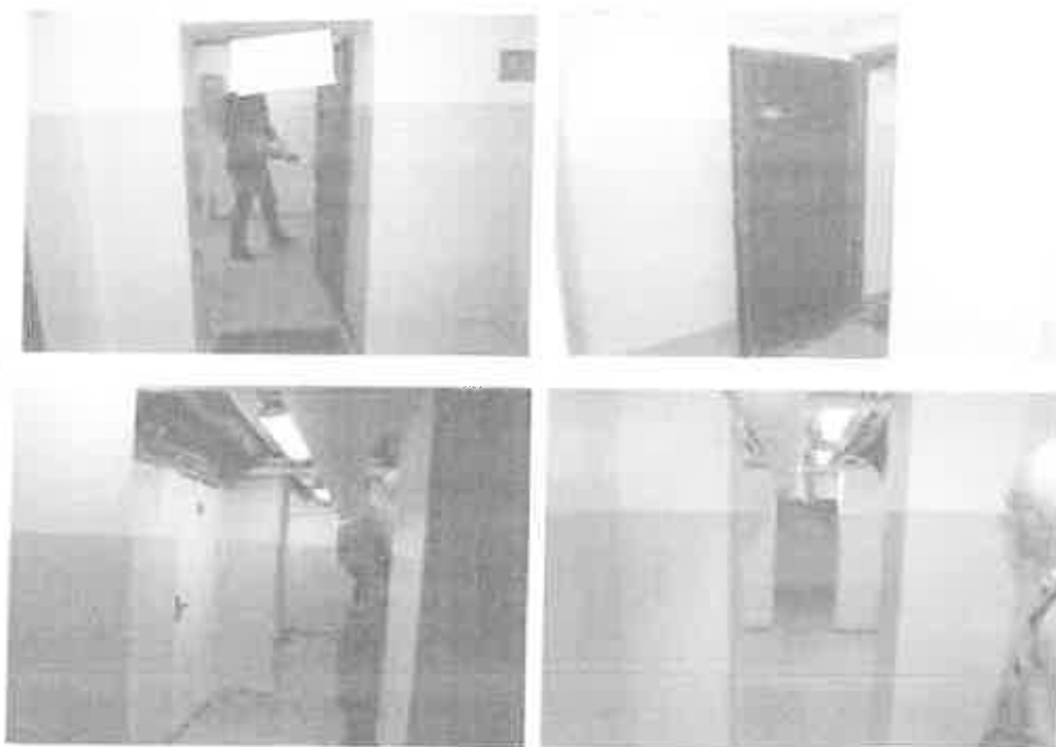
Fot.34 Budynek UM Inowrocław -- Ratusz -- kondygnacja podziemna w skrzydle A2 użytkowana w zakresie funkcji administracyjnej – trakt 2 (wykonał: kpt. Jarosław Skotnicki)
