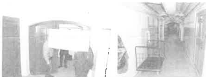
Fot.34 Budynek UM Inowrocław – Ratusz – kondygnacja podziemna w skrzydle A2 użytkowana w zakresie funkcji administracyjnej – trakt 1 (wykonał: kpt. Jarosław Skotnicki)
