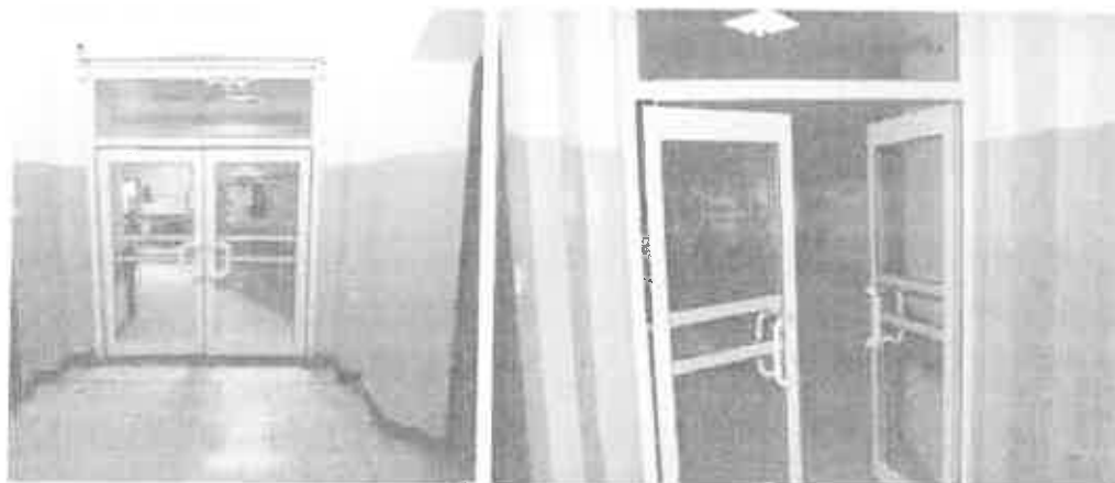
Fot.44 Budynek UM Inowrocław – segment B (Łącznik) – Poziomy odcinek dojścia ewakuacyjnego na kondygnacji II do wejścia do klatki K1 (wykonał: mł. asp. Maciej Borys)
