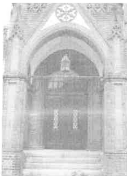
Fot.30 Budynek UM Inowrocław – Ratusz – nieużytkowana klatka schodowa K4 z wyjściem W 2 bezpośrednio na zewnątrz obiektu od strony elewacji wschodniej budynku. (wykonał mł. asp. Maciej Borys)
