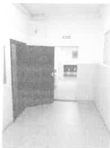
Fot. 20 Szpital UM Wrocław - Budynek - Fizjoterapia odroczona - widok z korytarza nr 2 na III kondygnacji podziemnej w skrzydle A2 od wejścia do windy K1 (wykonał: mgr. Jacek Januszewski)
