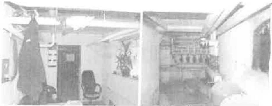
Fot.34 Budynek UM Inowrocław – Ratusz – kondygnacja podziemna w skrzydle A1 użytkowana w zakresie funkcji produkcyjno-magazynowej – warsztat i pomieszczenia techniczne (PM) (wykonak: ml. asp. Maciej Borys)
