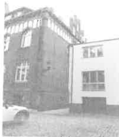
Fot.8 Budynek UM Inowrocław – Ratusz – elewacja zachodnia (wykonał: kpt. Jerzy Skotnicki)
