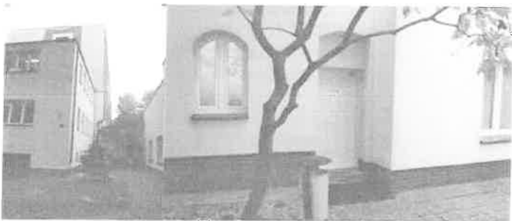
Fot.47 Budynek UM Inowrocław – segment C (Straż Miejska) – Elewacja północno zachodnia i wejście od strony elewacji wschodniej (wykonał: kpt. Jarosław Skotnicki)
