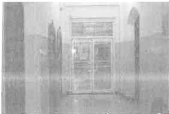
Fot.42 Budynek UM Inowrocław – segment B (łącznik) – wejście do BOI na I kondygnacji nadziemnej (wykonał: kpt. Jarosław Skotnicki)
