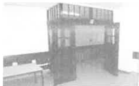
Fot.26 Budynek UM Inowrocław – Ratusz – Poziomy odcinek dojścia ewakuacyjnego nr 2 na II kondygnacji nadziemnej w skrzydle A2 do wejścia do klatki K1 (wykonał: mł. asp. Maciej Borys)
