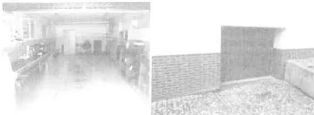
Fot.41 Budynek UM Inowrocław – segment B (łącznik) – widok kondygnacji z pomieszczeniami garażowymi (PM) (wykonał: kpt. Jarosław Skotnicki)
