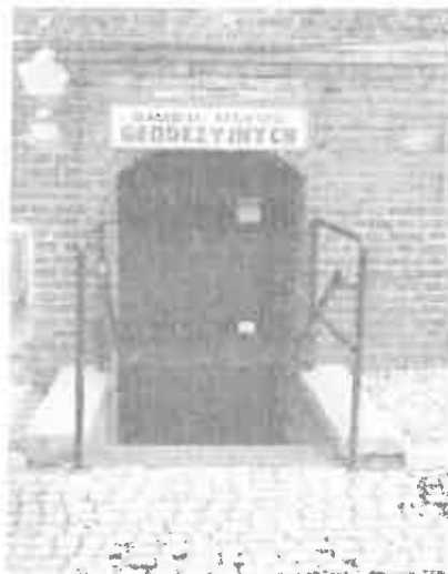
Fot.17 Budynek UM Inowrocław – Rausz – wejście W3 – elewacja zachodnia (wykonak kpt. Jercław Stotnicki)
