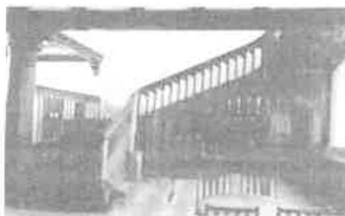
Fot.28 Budynek UM Inowrocław – Ratusz – Poziomy odcinek dojścia ewakuacyjnego nr 2 na II kondygnacji nadziemnej w skrzydle A2 – odcinek komunikacji schodami drewnianymi zlokalizowanymi w otwartej klatce schodowej wychodzącej na analizowane dojście ewakuacyjne. (wykonał: mł. asp. Maciej Borys)
