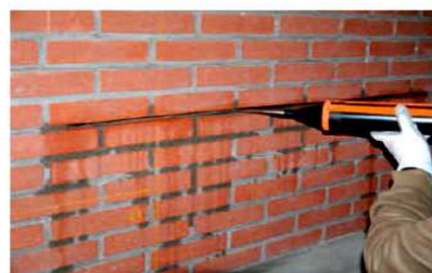
Aplikacja pierwszej warstwy zaprawy festmörtel
