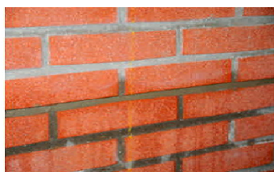
Zatopienie spirali festspiro w zaprawie festmörtel
