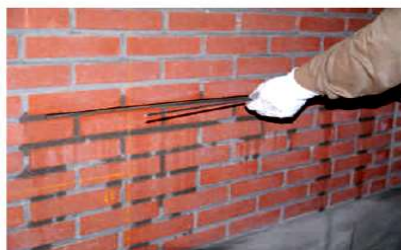
Zatopienie spirali festspiro w zaprawie festmörtel
