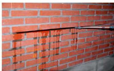
Oczyszczenie i zmoczenie bruzdy
